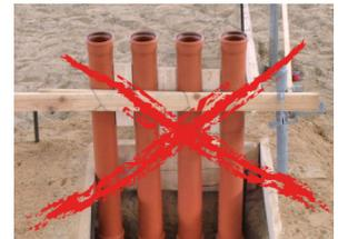
Hauseinführungen müssen für die geplante Verwendung geeignet und zugelassen sein. Durch nicht zugelassene Leerrohre ist die Gas- und Wasserdichtheit gemäß DIN 18322 und DVGW VP 601 nicht gewährleistet.
